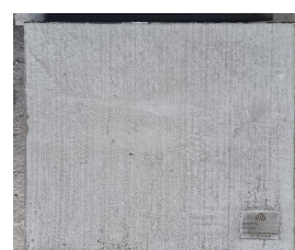
TAPA CONCRETO CAJA DE PASO ANDEN ETB
